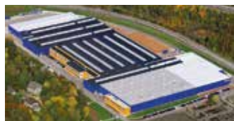
Hörmann KG Eckelhausen, Allemagne
